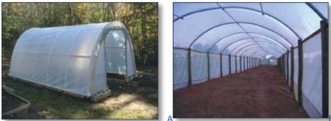
Figura 72 – Estufa hemicilíndrica (A) estrutura mista (madeira e metal) (B)
